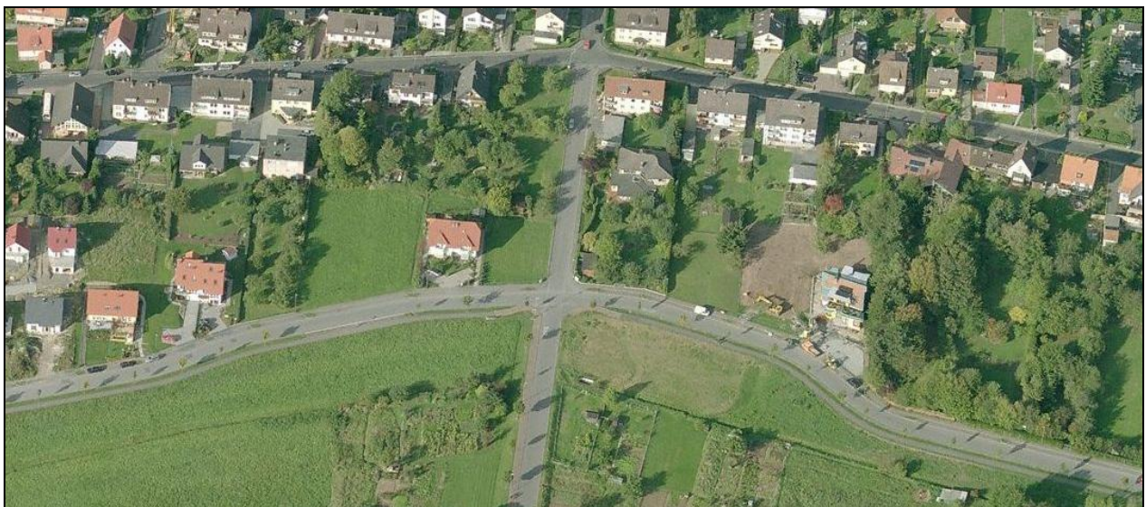
Abbildung 35: Knotenpunkt Cornelius-Gellert Straße / Am Stein
