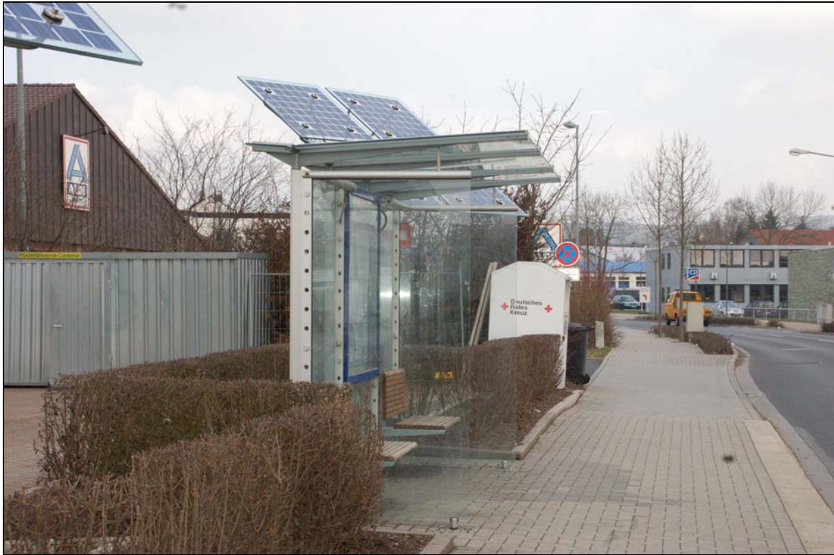
Abbildung 22: Beispiel für eine gut ausgestattete Haltestelle (SMA)
